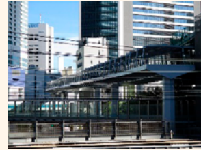
浜松町駅関連の改良工事
