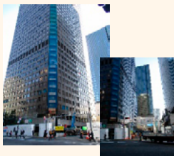
解体間近のセンタービル
