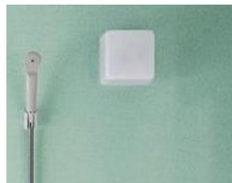
システムバスの壁付け照明の例
